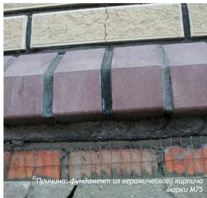
Причина: толстый слой бетона в фундаменте
