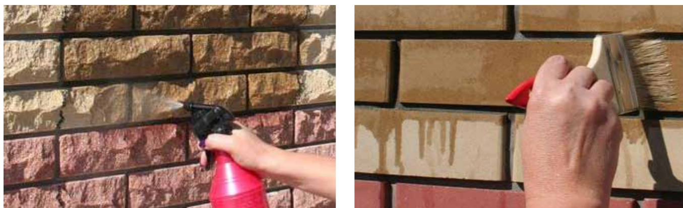
Нанесения гидрофобизатора распылителем или кистью
