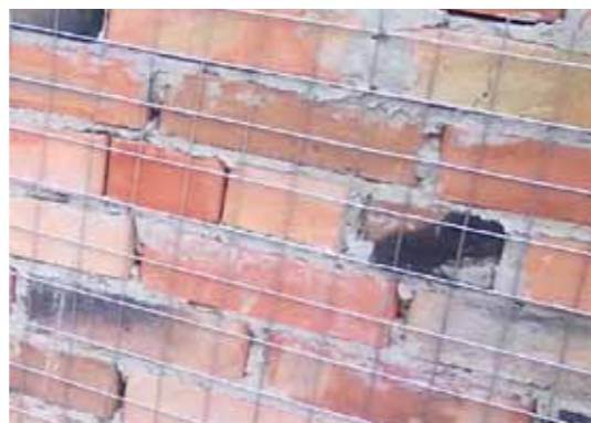
Армирующая металлическая сетка
